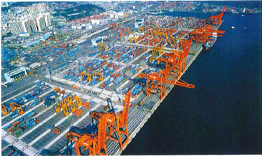
韓国 釜山新港北コンテナ背後敷地造成全景
