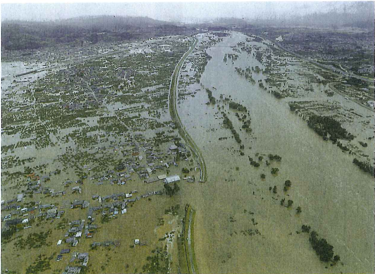
台風による大雨で増水、氾濫した千曲川。中央下の堤防が決壊した—長野市穂保で13日午前8時15分、本社ヘリから
